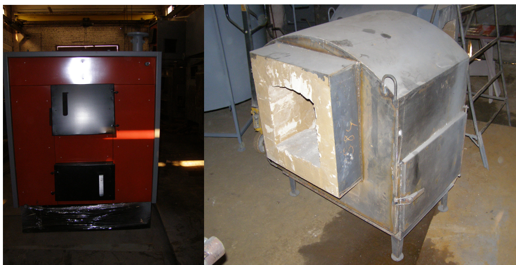
Рис. 3. Система спалювання фірми «Металіст»
