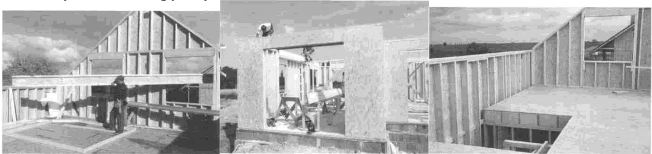
Рис. 4. Фрагменти використання плити OSB при спорудженні будинків
