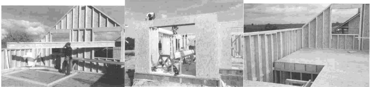
Рис. 4. Фрагменти використання плити OSB при спорудженні будинків
